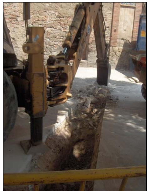
FOTO 8. Vista dels treballs d'obertura de la rasa 4 ( carrer Parellada)
