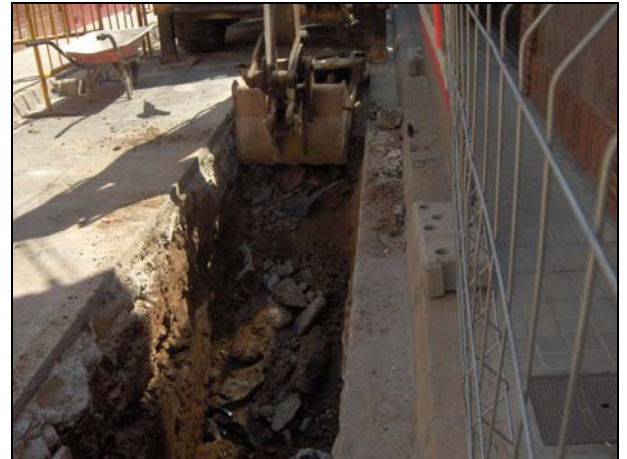
FOTO 10. Execució dels treballs mecànics a la rasa 6 (Passatge de l'estació)
