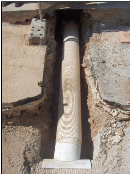
FOTO 15. Rasa 10 un cop finalitzada (Passatge de l'estació)
