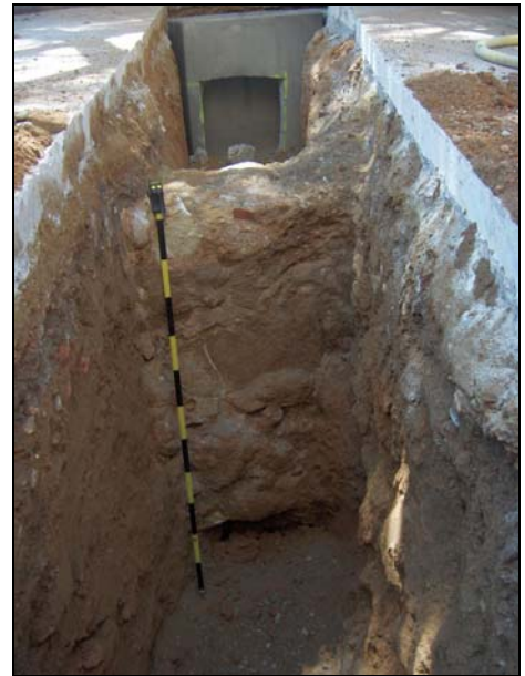
FOTO 6. Detall del parament del mur UE 05 (rasa 5 del carrer Parellada)
