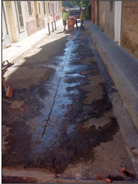
FOTO 9. Vista general del Passatge de l'estació abans d'iniciar l'obertura de la rasa 6
