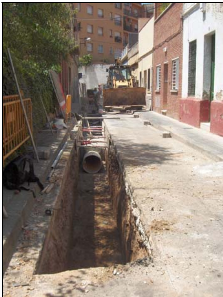
FOTO 11 Vista general de la rasa 6 (Passatge de l'estació)
