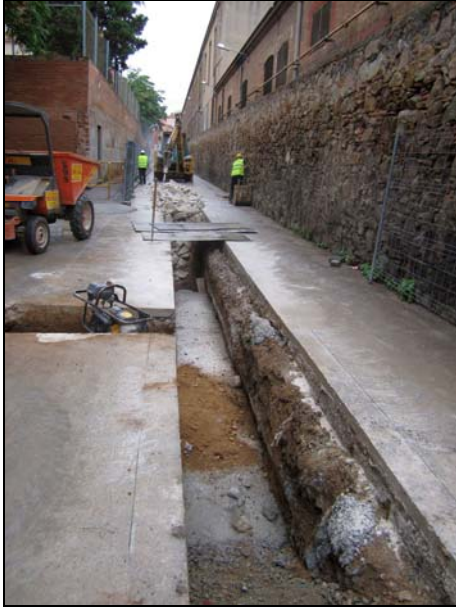
FOTO 1. Vista general i situació de la rasa 1 del carrer Parellada
