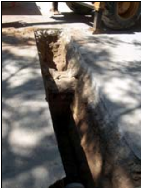
FOTO 3. Vista general de la rasa 3 amb l'ubicació del mur UE 05 ( carrer Parellada)
