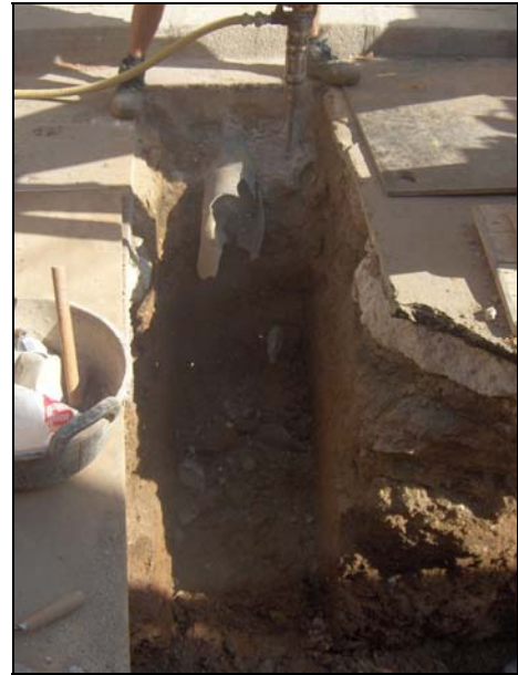
FOTO 14. Vista de la rasa 9 (Passatge de l'estació)
